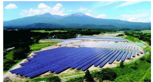
建設中の庄内・遊佐太陽光発電所（山形県）
